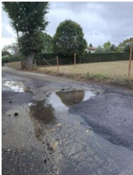
2) Da oltre 10 anni l'acquedotto della strada è sottoposto a continue e ravvicinate rotture, mediamente 3/4 volte al mese, con costi rilevanti per la collettività e notevole dispersione di acqua pubblica.
