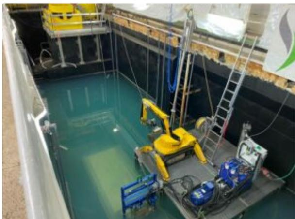
Sessa Aurunca- Nella centrale nucleare del Garigliano (Caserta) Sogin ha terminato la rimozione dei componenti metallici contaminati posizionati sul deflettore, la parte superiore del vessel, il contenitore d'acciaio nel quale durante l'esercizio avveniva la reazione nucleare.
